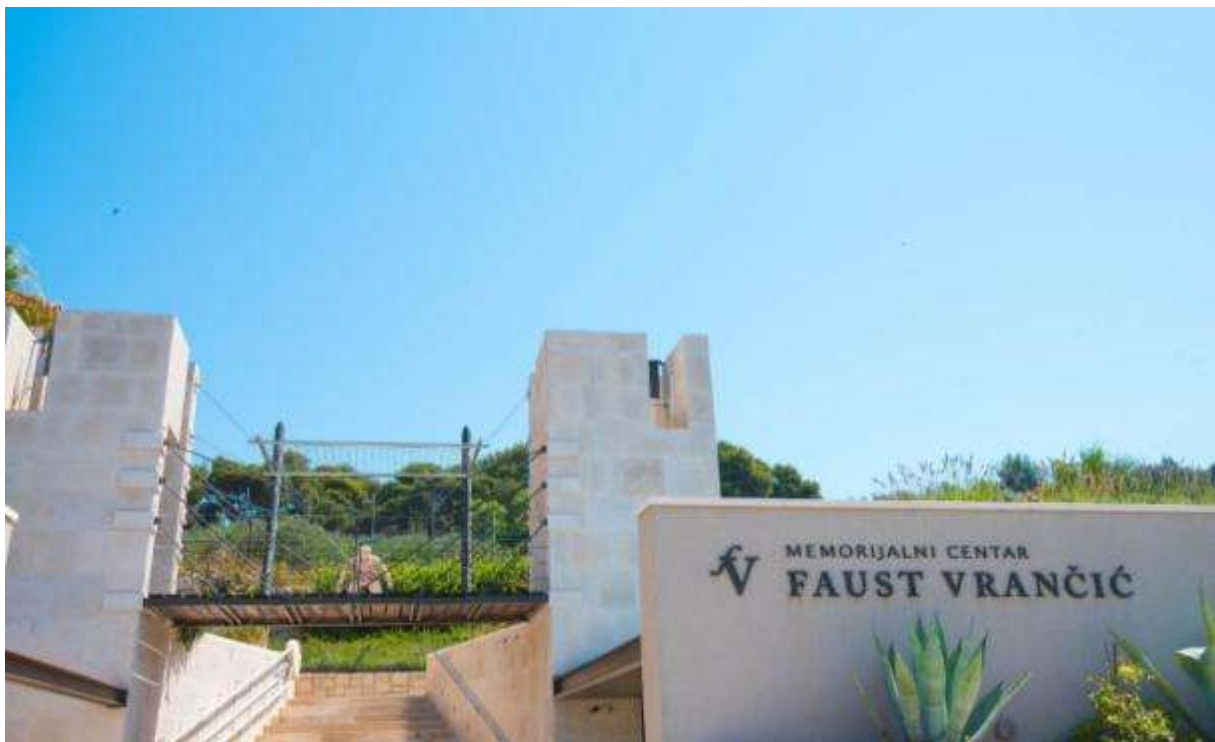
Slika 1. Pogled na pročelje zgrade MC Faust Vrančić
